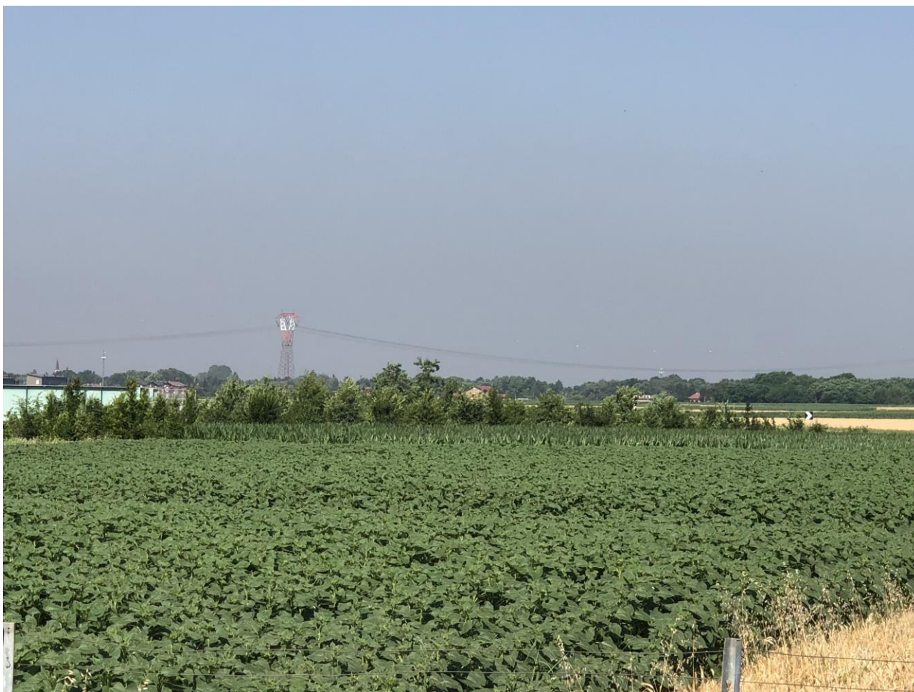
Figura 8 – particolare delle mitigazioni presso il cavalcavia di via Vittorio Veneto, scattata dalla strada consorziale Mombello (a nord dell'A36)
